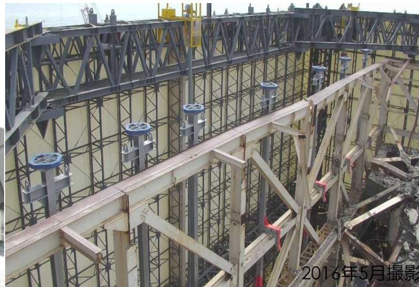
ノズルユニット設置状況
