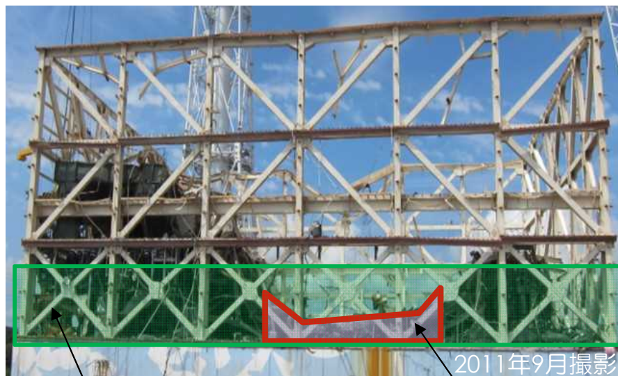
防風シート 原子炉建屋東側写真 ウェル近傍の空間
