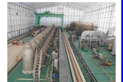
(高性能多核種除去設備)
