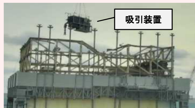
<進捗状況(1/22撮影)>
