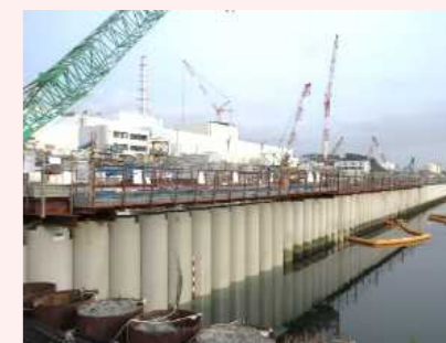
海側遮水壁 鋼管矢板打設完了状況
