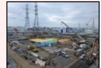
H1東エリア解体後の様子
