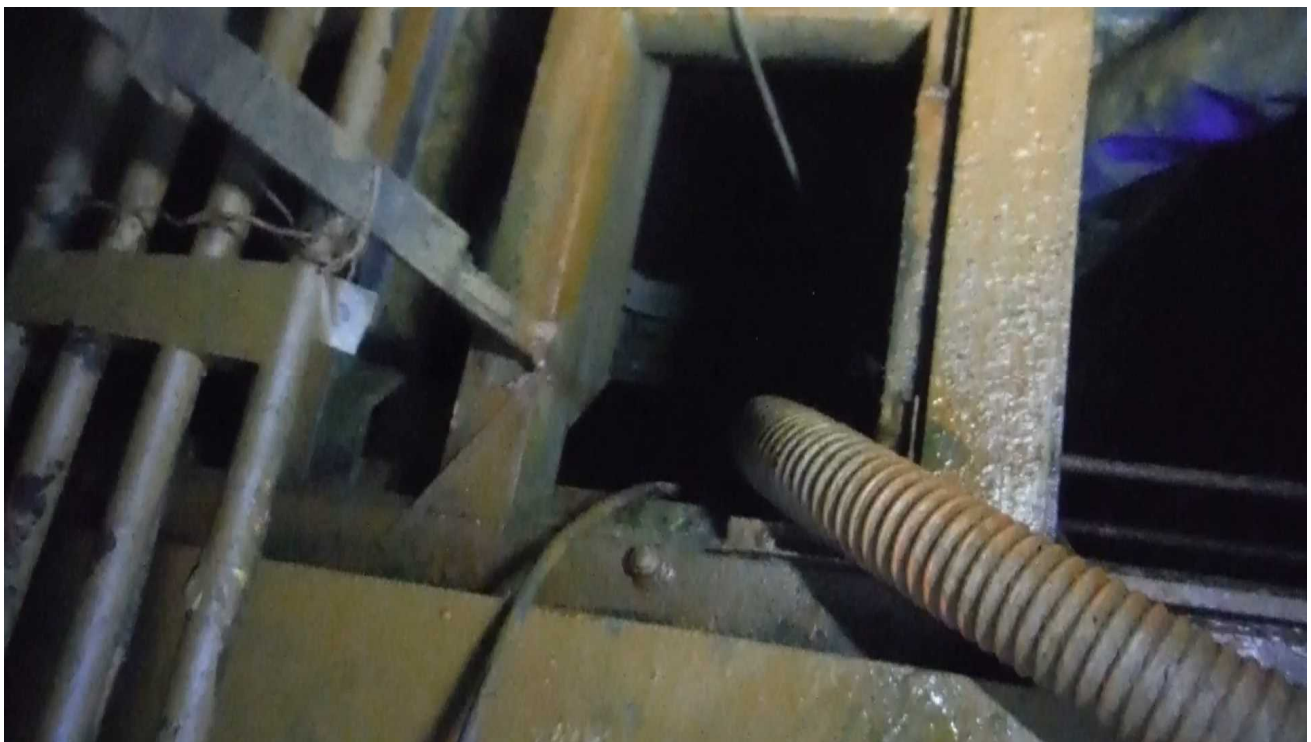
サンプタンク流入状況
