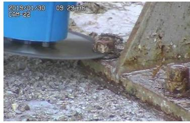
ボルト・ナット切断の様子 (拡大)
