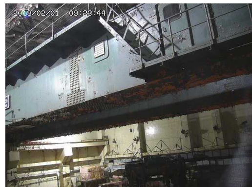
【天井クレーン】
