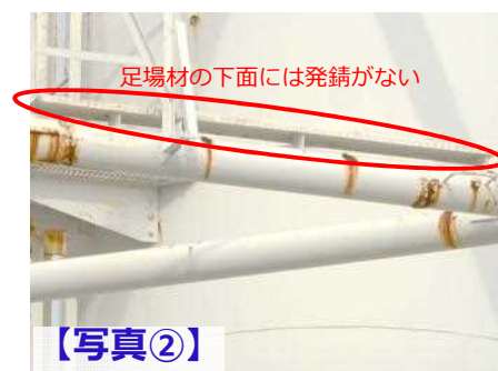
【写真②】 3/4号機 健全と推定される足場材 北面 地上18m付近
