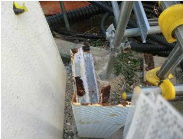
落下した足場
