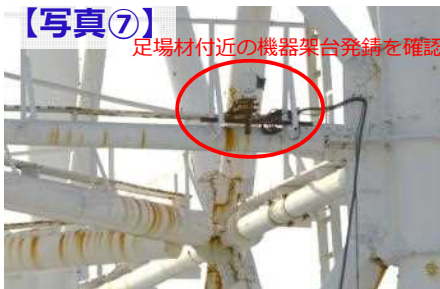
タービン建屋集中 劣化が疑われる機器 北面 地上42m付近
