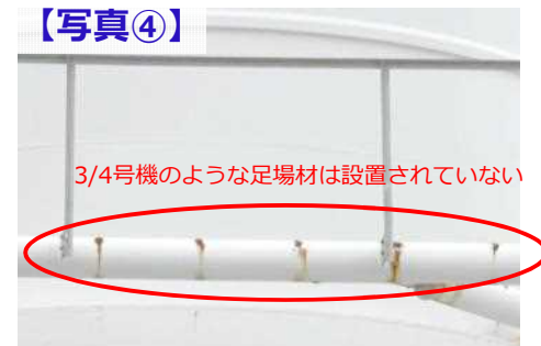
【写真④】 5/6号機の鉄塔 南面 地上76m付近
