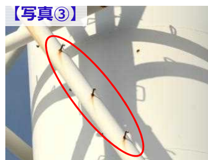
【写真③】 3/4号機 劣化進行が疑われるステップ 東面 地上100m付近
