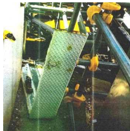
落下した点検用の足場
