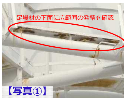
【写真①】 3/4号機 劣化進行が疑われる足場材 北面 地上67m付近
