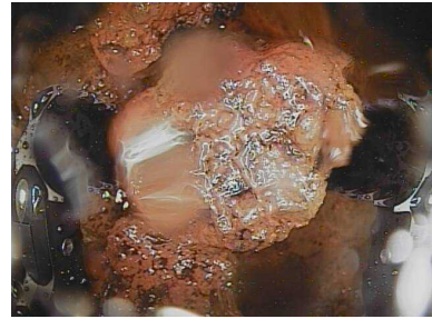
底部-4の調査状況
