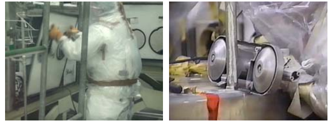
図1 既存のホット施設でのグローブボックス解体作業の例
