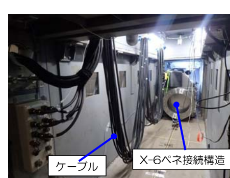
隔離部屋内作業（ケーブル配置状況）
