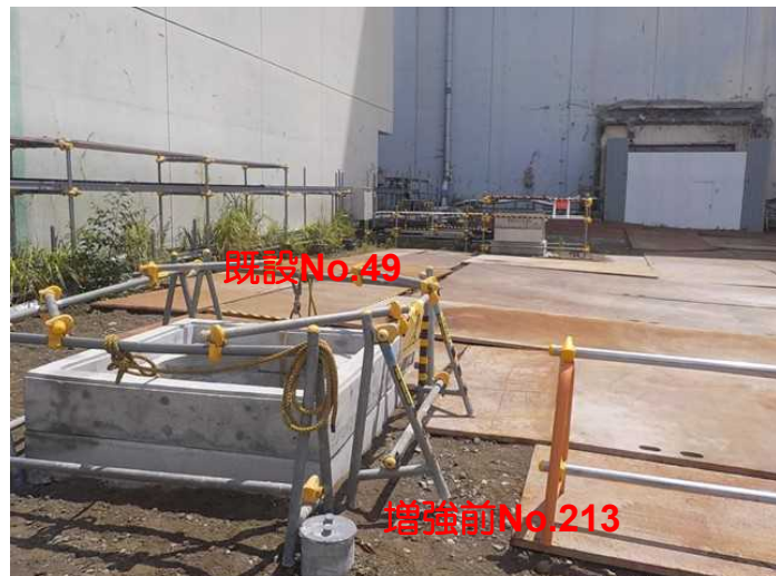
No.49ピット周辺
