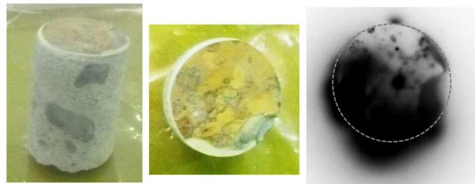
コア抜きコンクリートサンプル①
